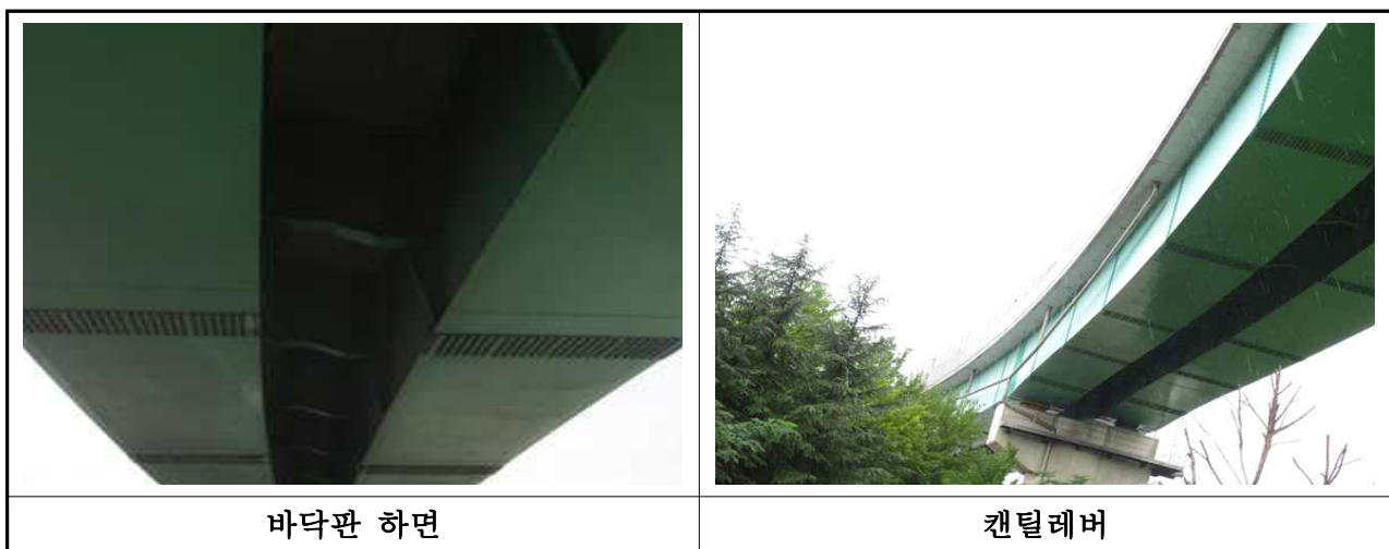
【사진 3.2.1】 바닥판 전경
