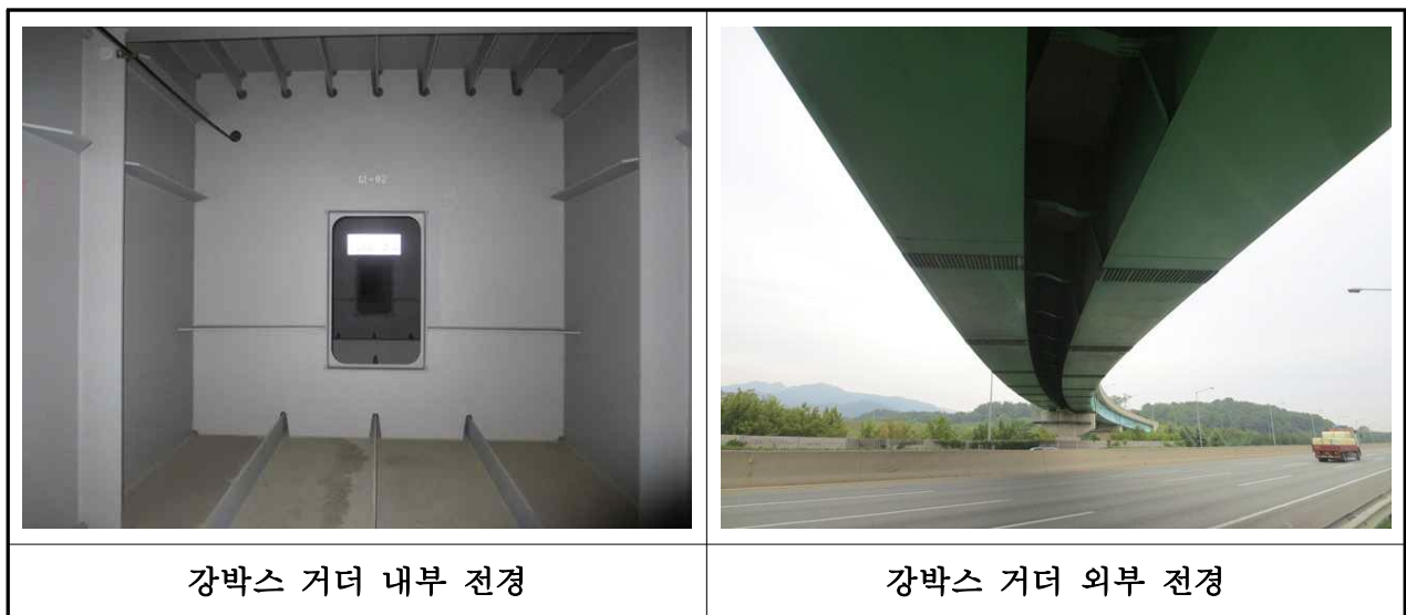
【사진 3.2.3】 강박스 거더 전경
