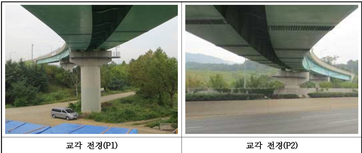
【사진 3.2.9】 교각 전경
