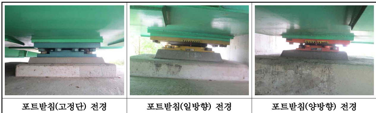
【사진 3.2.11】 교량받침 전경
