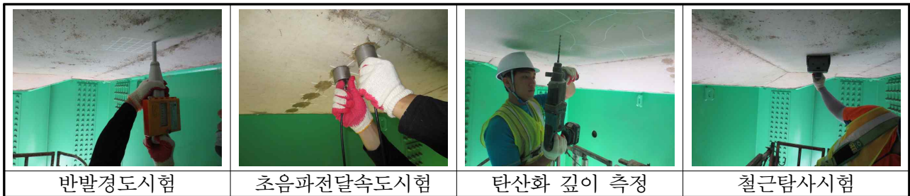
【사진 3.3.1】 콘크리트 내구성조사 전경
