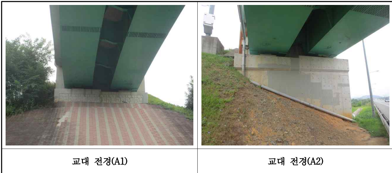
【사진 3.2.7】 교대 전경
