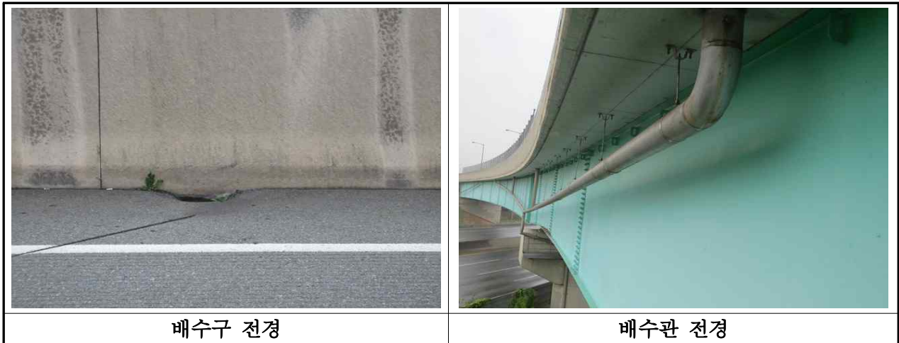
【사진 3.2.19】 배수구 및 배수관 전경
